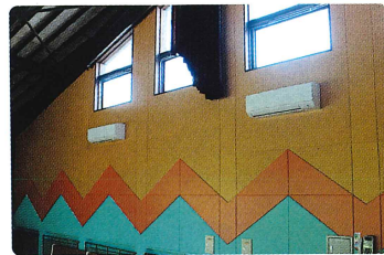
エアコン(4台)と新しくなった壁
